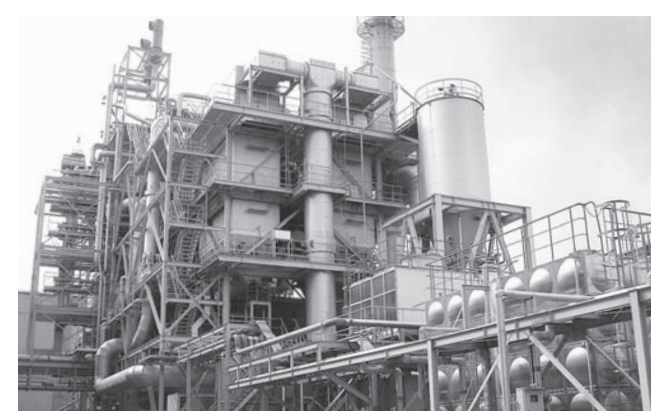
白河ウッドパワー 大信発電所 株式会社白河ウッドパワーの木質バイオマス発電所。燃料に使用するのは100%木質チップ。2011年2月の株式譲渡契約により、日本テクノが同社の親会社となる。この発電所が商業運転を開始したのは、2006年10月から。発電能力は、1万1500kW。
