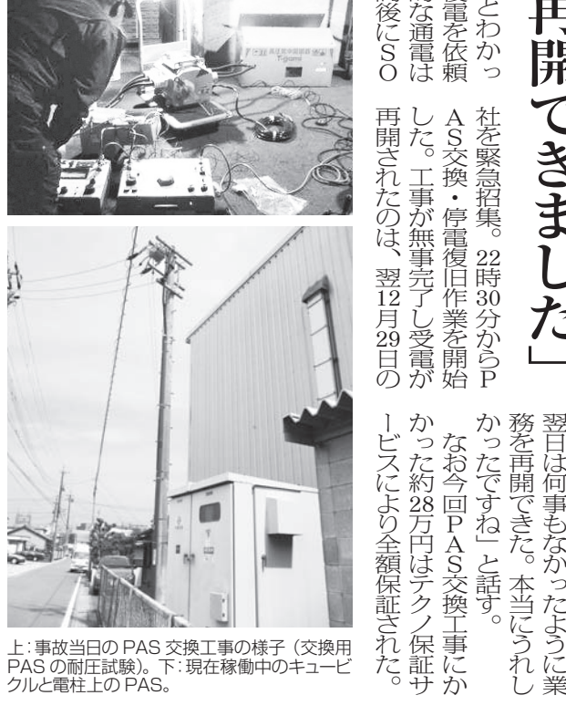
▲事故当日のPAS交換工事の様子(交換用PASの耐圧試験)。下:現在稼働中のキュービクルと電柱上のPAS。
