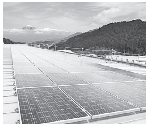
雄大株式会社 太陽光パネル設置の様子
