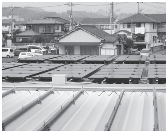
工場増設でパネル数を増やし、影になる手前部分の(1)パネルは別の屋根に移設した。
