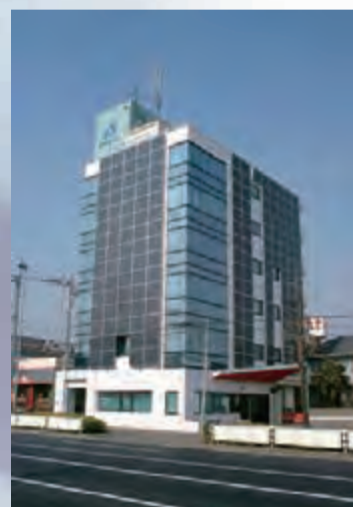
日本テクノ ソーラーパワービル 30kW
