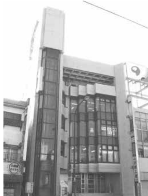
日本テクノ沖繩コールセンターのあるビル。ここに全国のお客さまからのさまざまなお問い合わせが寄せられ、集中管理されています。
