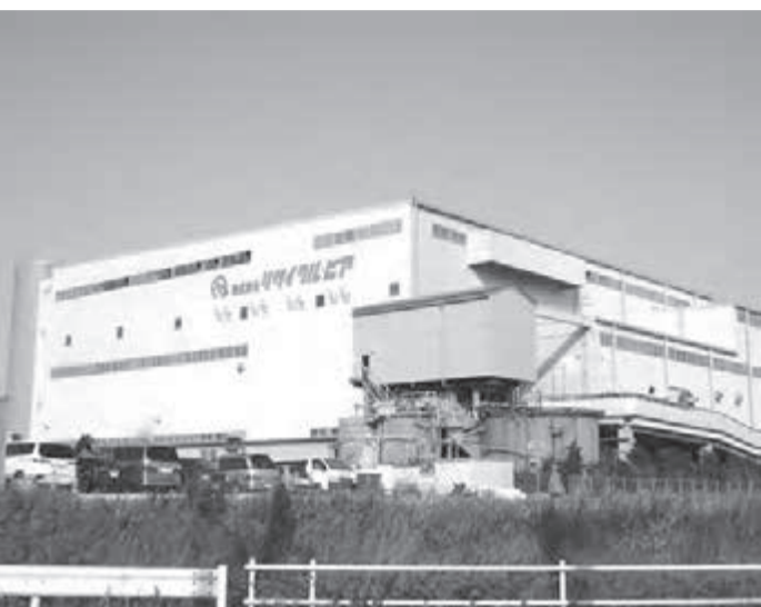
2005年1月に竣工したリサイクル・ピア「東京エコタウン工場」。高度な技術を結集したリサイクルモデルとして注目されている。
